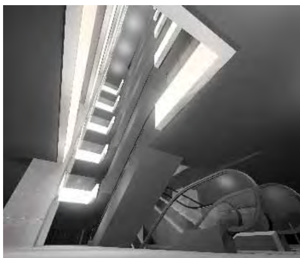
2F ~ 7F エスカレーターサイド吹き抜け
